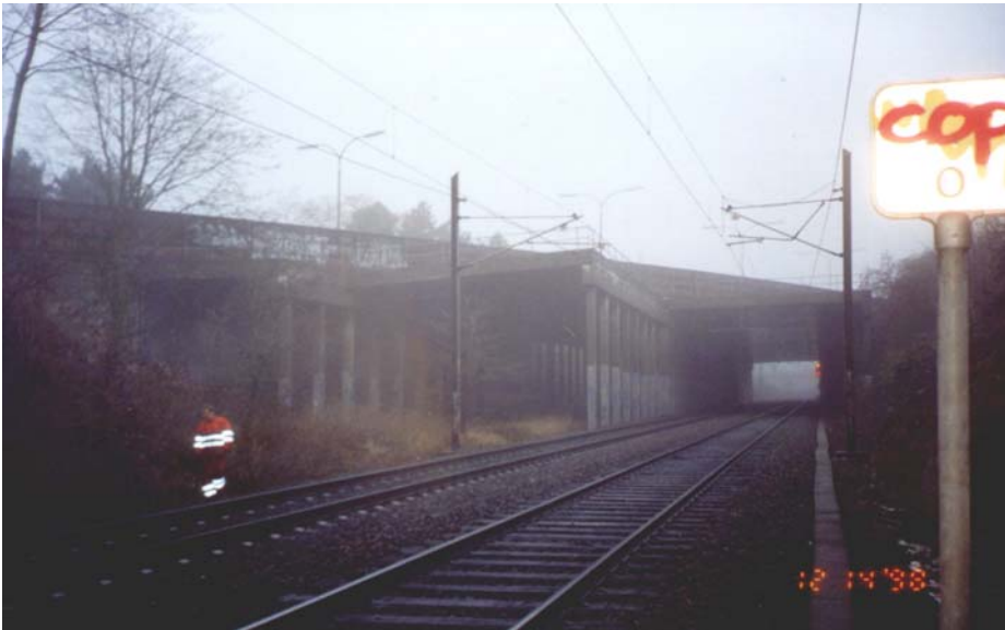
Figur 3 I forbindelse med vedligehold af denne bro blev der valgt at standse den videre nedbrydning ved installation af katodisk beskyttelse på de chloridbelastede konstruktionsdele.
