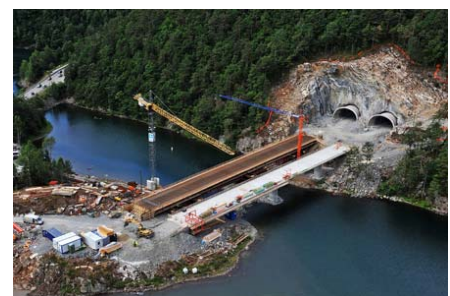
Bro og tunnel på den nye E-18 parallelt med den eksisterende hovedvej.
