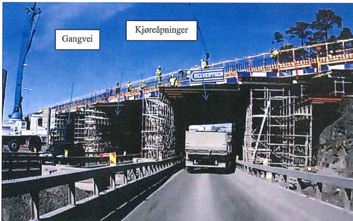
Figur 3-1. Midlertidig primærbæresystem for Rotvollhaugen bru pr 13:08, 8 Mai 2013.
