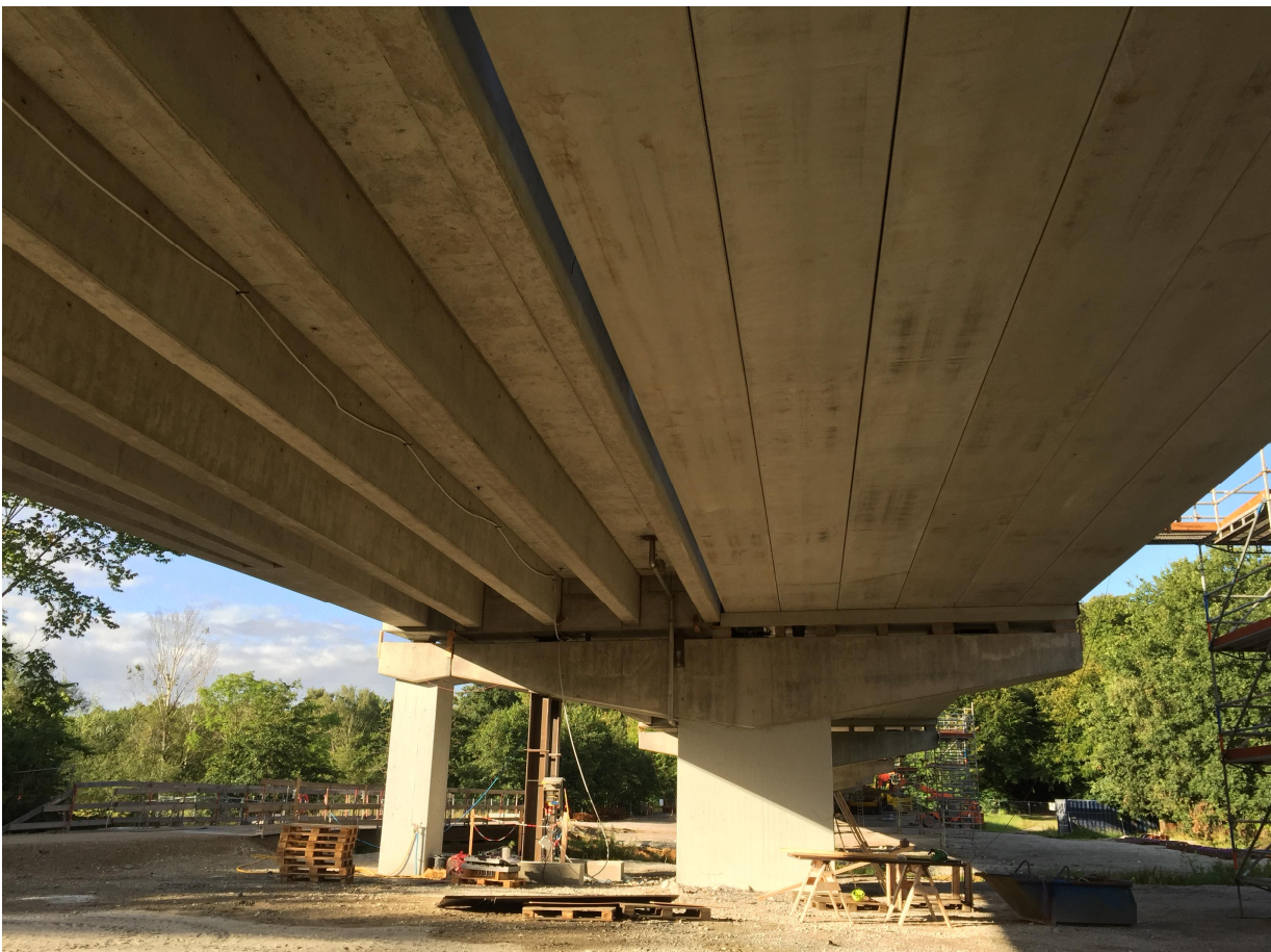
Figur 2 Eksisterende bro (venstre) og ny bro (højre) (september 2015)
