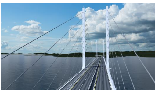
Ret linjeføring, enkelt-cellet stål-kassedrager
