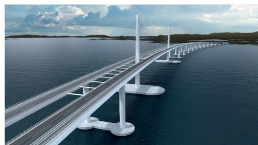
Krum linjeføring, dobbelt stål-kassedrager forbundet med tværbjælker
