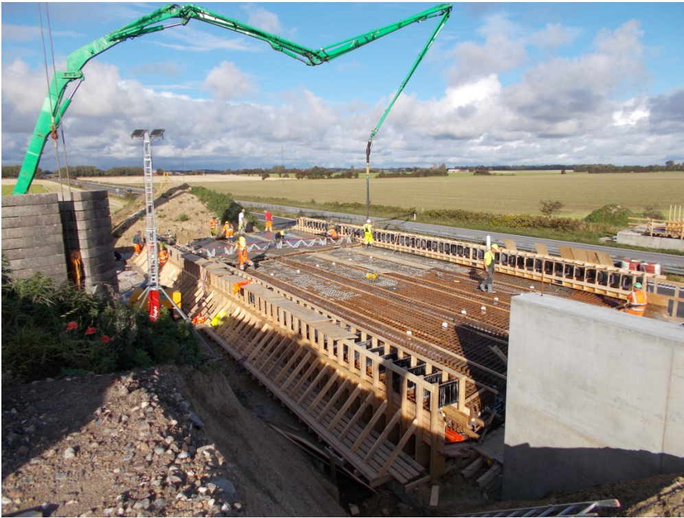
Foto 1: Støbning af de 10 første elementer. På billedet anes hvordan formen er inddelt i 10 sektioner der udstøbes i én samlet støbning.
