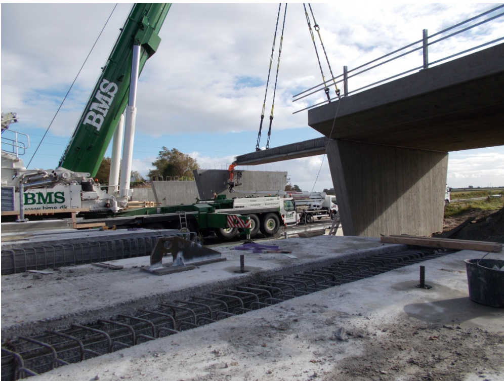
Foto 2: Montage af brodæksselementer. Elementerne blev hejst på plads og udspæringer blev færdigarmeret så elementerne efterfølgende kunne støbes sammen.
