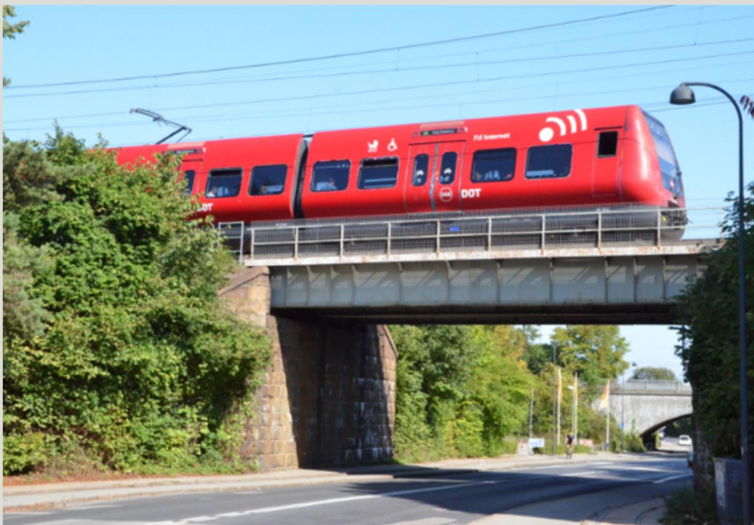
Del af Københavns befæstning. Bro over Ermelundsvej, Gentofte. Automatisk fredet.
