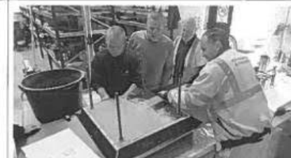
Foto 8: (Der afprøves forskellige trykmetoder og resultatet ses tydeligt, samt der udveksles erfaring. Metoden med et godt tryk ind i mørtlen og der så skubbes fra side til side med en let skrå flade, gør at understopning trykkes bedst mulig sammen.)
