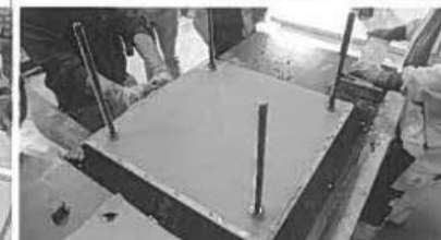
Foto 10: (Godkendt resultat. De små lufthuller der ses i venstre hjørne, er grundet mørtlen skubber sig selv ud, idet vi kun har understoppet fra en side, som faktiske forhold og vi kun har 2 forskallingssider oppe. På stedet forskalles 3 sider. Som overflade ses der, er den godkendt fra MB Projekt.)
