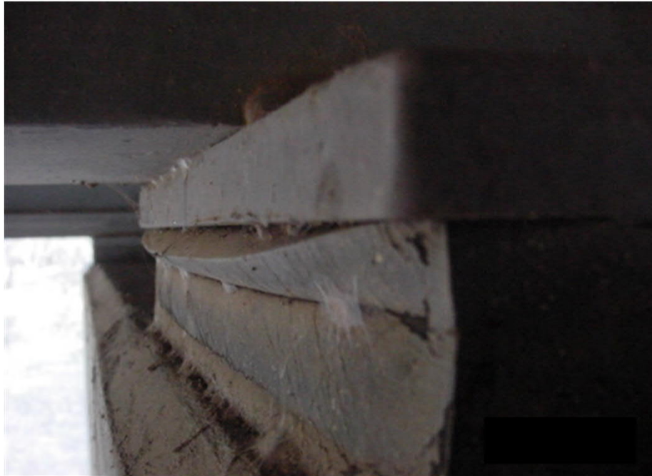
Elastomerlejer med vulkaniseringssvigt: Fabrikationsfejl og/eller for store bevægelser (translation eller rotation)
